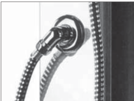
montaż węża prysznica do wylotu armatury
